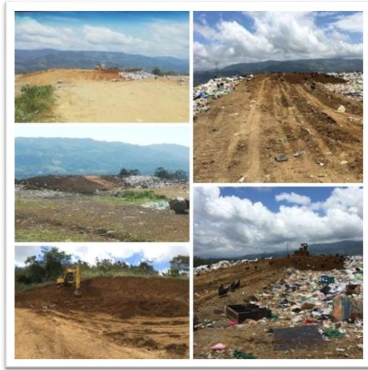
Ilustración 21. Labores de cobertura de los residuos sólidos
